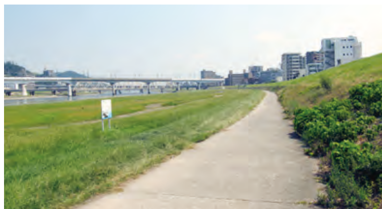
緊急用河川敷道路（太田川放水路）
